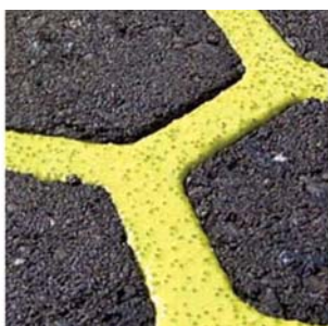
Figura 40 – Disegni e tonalità (a sx) - Stampa contestuale alla stesa del conglomerato - Imprimitura (a dx)
