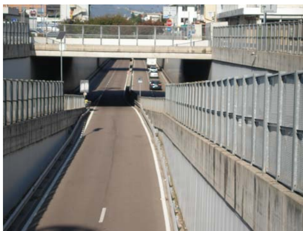
Figura 61 – Foto dello stato attuale del tratto oggetto di riqualifica di Viale delle Nazioni
