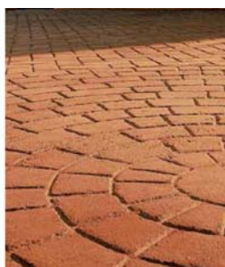
Figura 40 – Disegni e tonalità (a sx) - Stampa contestuale alla stesa del conglomerato - Imprimitura (a dx)
