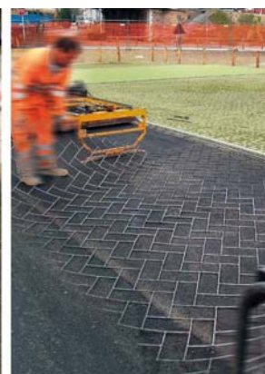
Figura 40 – Disegni e tonalità (a sx) - Stampa contestuale alla stesa del conglomerato - Imprimitura (a dx)
